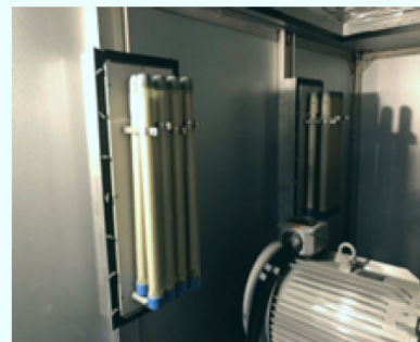
給気ファン室内設置 (508FC x 2台)
