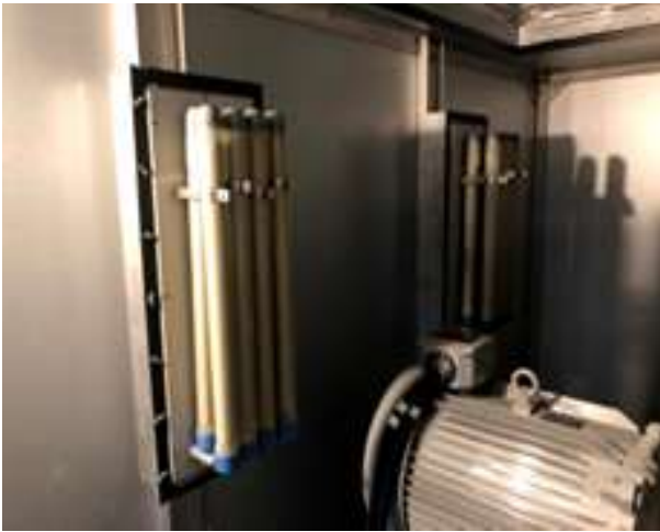
給気ファン室内設置 (508FC x 2台)
